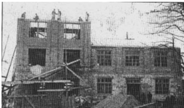
Joonis 3. Jööri-Kõnnu Masinatarvitajate Ühisuse veskile kolmanda korruse ehitamine 1935. a.
